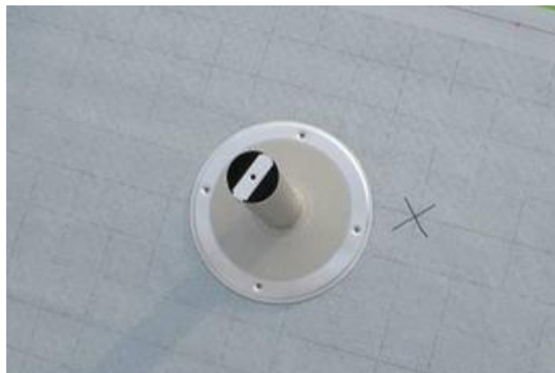
1 設置場所の決定とビス穴の印をつける
