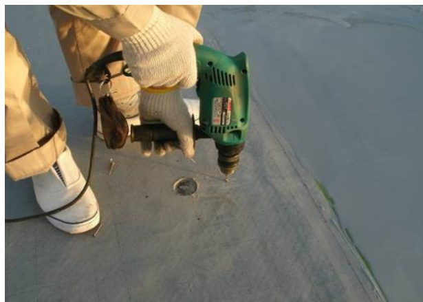
3 振動ドリル(φ4.5mm)でビス穴を開ける
