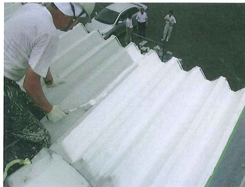
ローラー塗り (多孔質ローラー)
