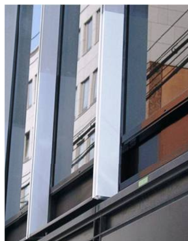
非クリア系塗料を塗布したアルミ建材
